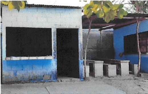
Foto 7: Reemplazo de techo de lámina de cocina y comedor.
