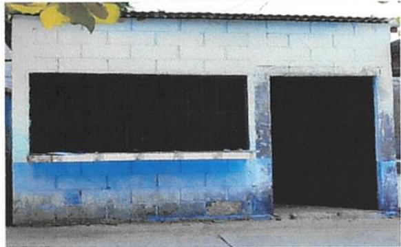
Foto 8: Reemplazo de pintura interior y exterior de cocina.
