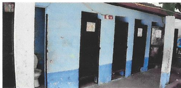
Foto 4: Reemplazo de sanitarios.
