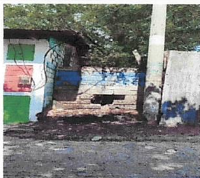
Foto 1: Cerramiento de muro perimetral.
