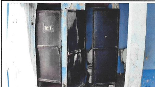
Foto 2: Mantenimiento de puertas de baños.
