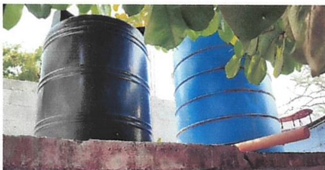
Foto 3: Reemplazo de tinaco de 1,250 litros
